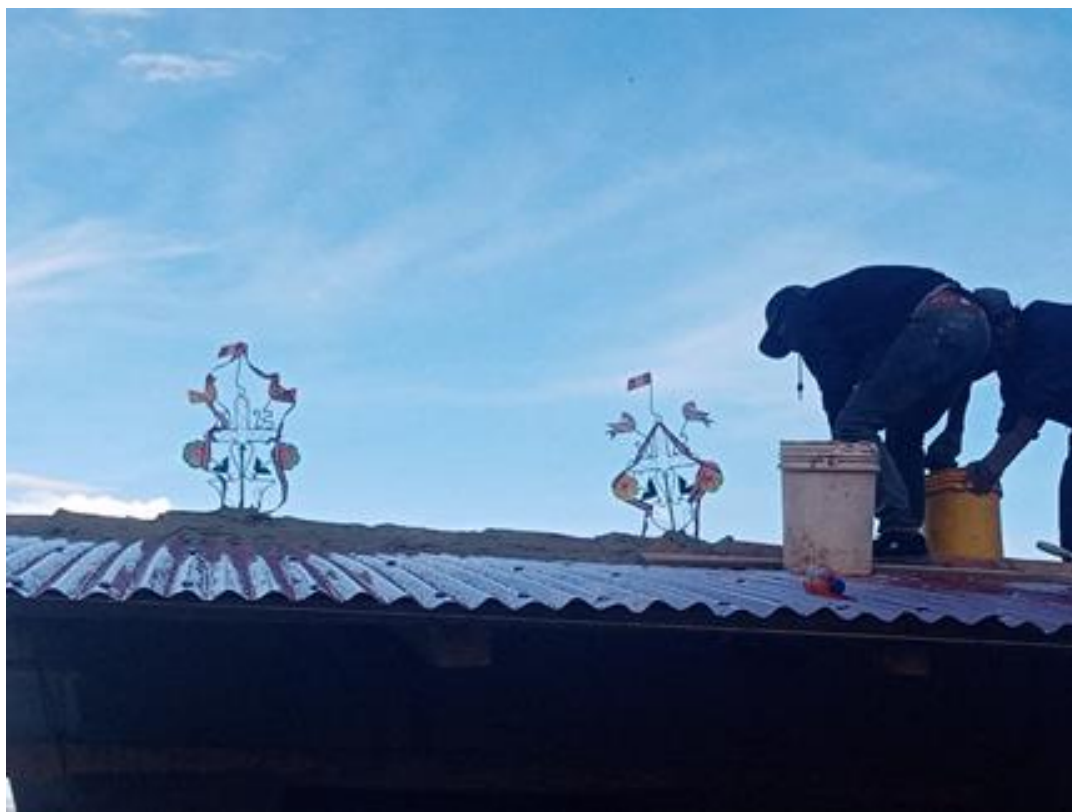
Foto 17: Colocación de la cruz de metal en el techo de la vivienda concluida
