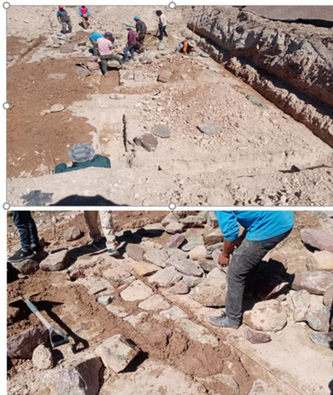
Foto 9: Hombres colocando el cimiento para la nueva casa
