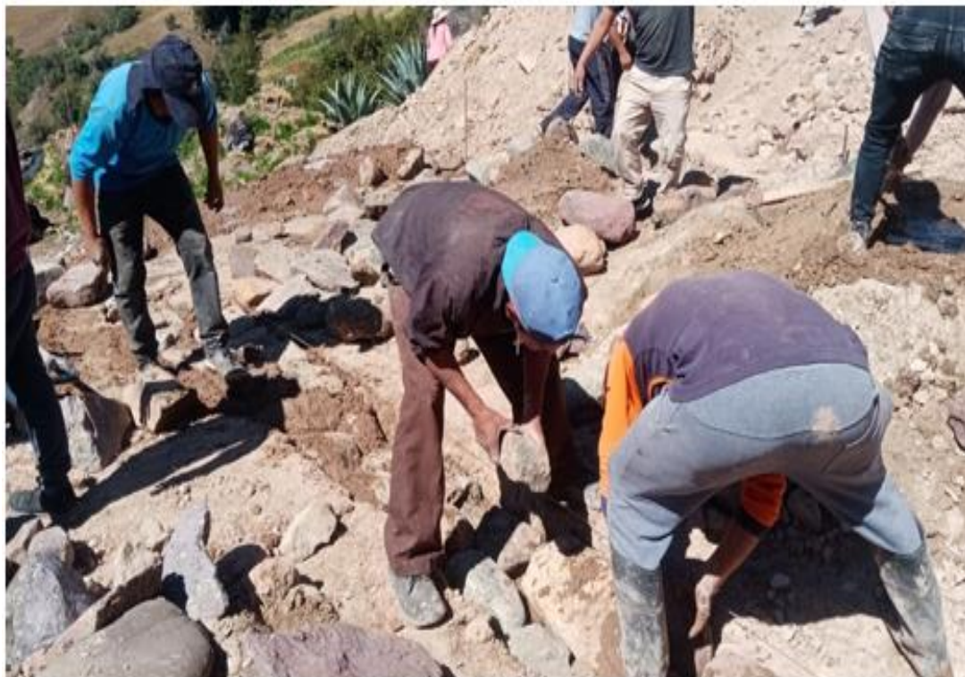
Foto 1: Colocación de la base del armazón
