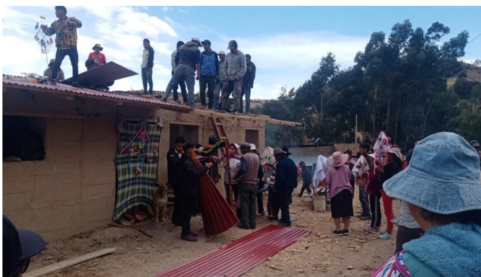
Foto 16: Colocación de la cruz de metal
