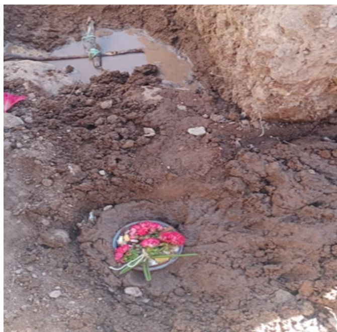
Foto 8: Cruz colocada en los cimientos
