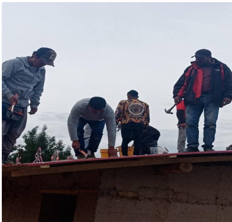
Foto 18: Colocación de la cruz
